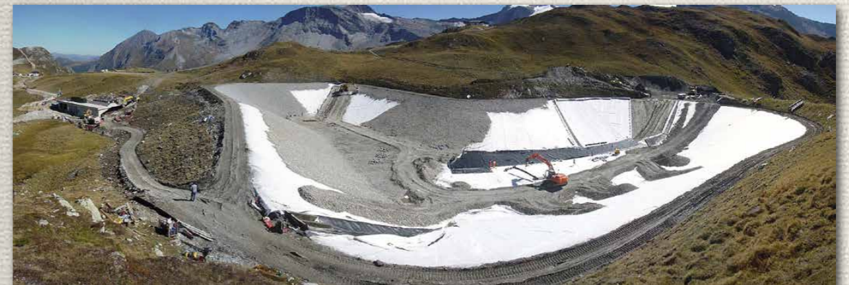
Errichtung des Speicherteiches Tuxerjoch im September 2008. Der Speicherteich verfügt über ein Volumen von ca. 70.000 Kubikmetern. Ein Größenvergleich mit den im Bild zu sehenden Baumaschinen verdeutlicht die Dimensionen dieser hochalpinen Baustelle!
