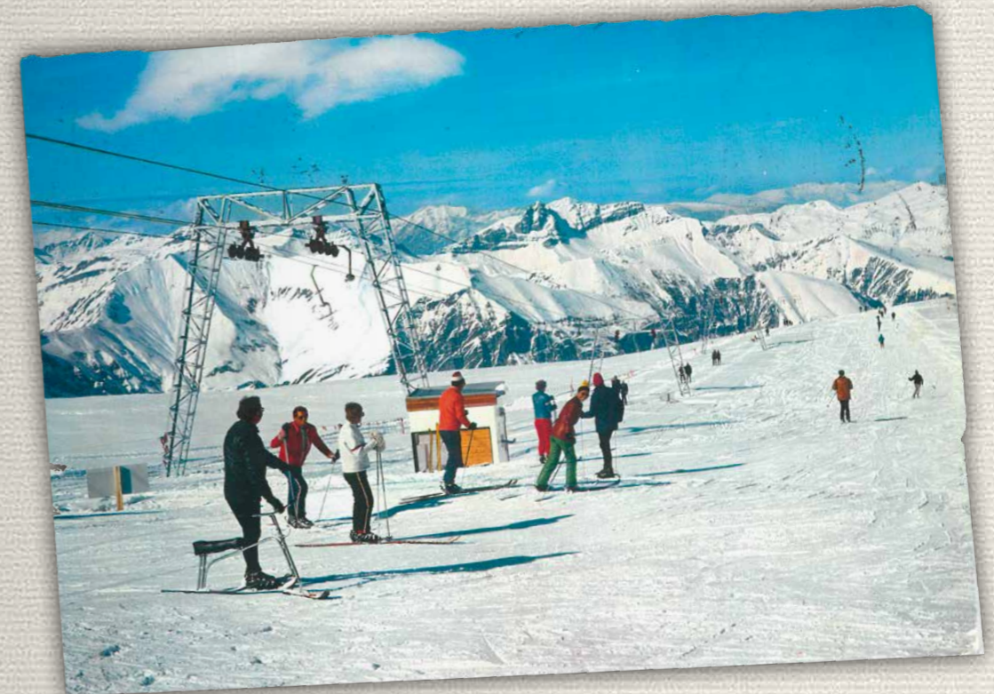
Schlepplift Olperer von 1969-1971 Der erste Gletscherschlepplift Tirols (bis zu 55 Meter/Jahr) und des noch Fließgeschwindigkeit des Gletschers (bis zu 55 Meter/Jahr) und des noch nicht vorhandenen „Know Hows“ nach 1,5 Jahren wieder abgetragen werden
