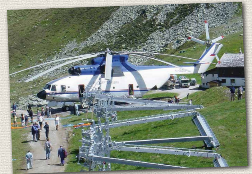
Beim Bau des Schlepliftes Kaserer I im Jahr 2005 am Hintertuxer Gletscher war der Einsatz des größten und stärksten Hubschraubers der Welt, des „MIL 26“, erforderlich
